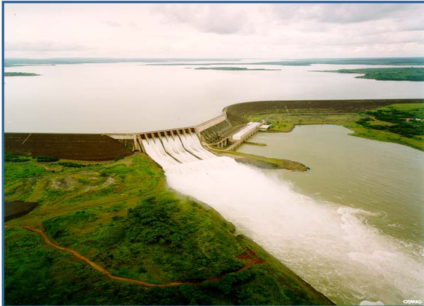
Foto da Usina de São Simão
