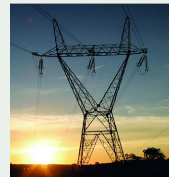
Entrada em operação das Linhas de Transmissão Itutinga-Juiz de Fora - 345 kV e Irapé-Aracuaí - 230 kV
