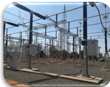
SE Volta Grande New equipment
